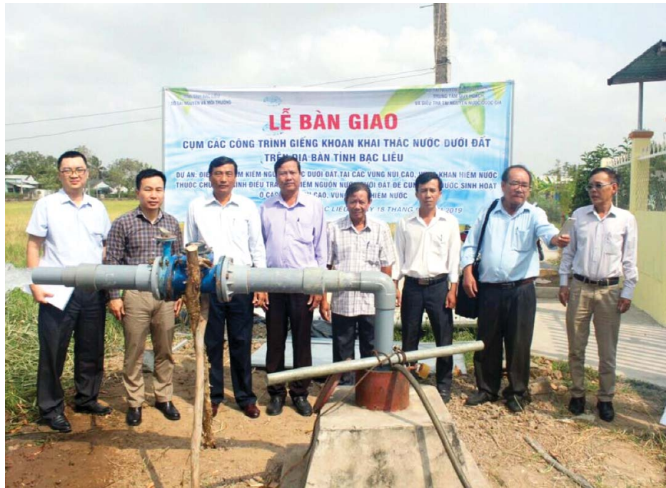
Bàn giao cụm công trình VCBL 12 công suất 1300 m 3 /ngày.đêm tại ấp Cù Lao, xã Hưng Hội, huyện Vĩnh Lợi, tỉnh Bạc Liêu
