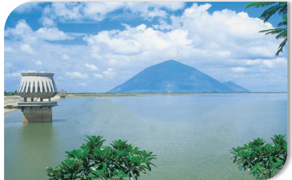
Công trình thủy lợi Hồ Dầu Tiếng
